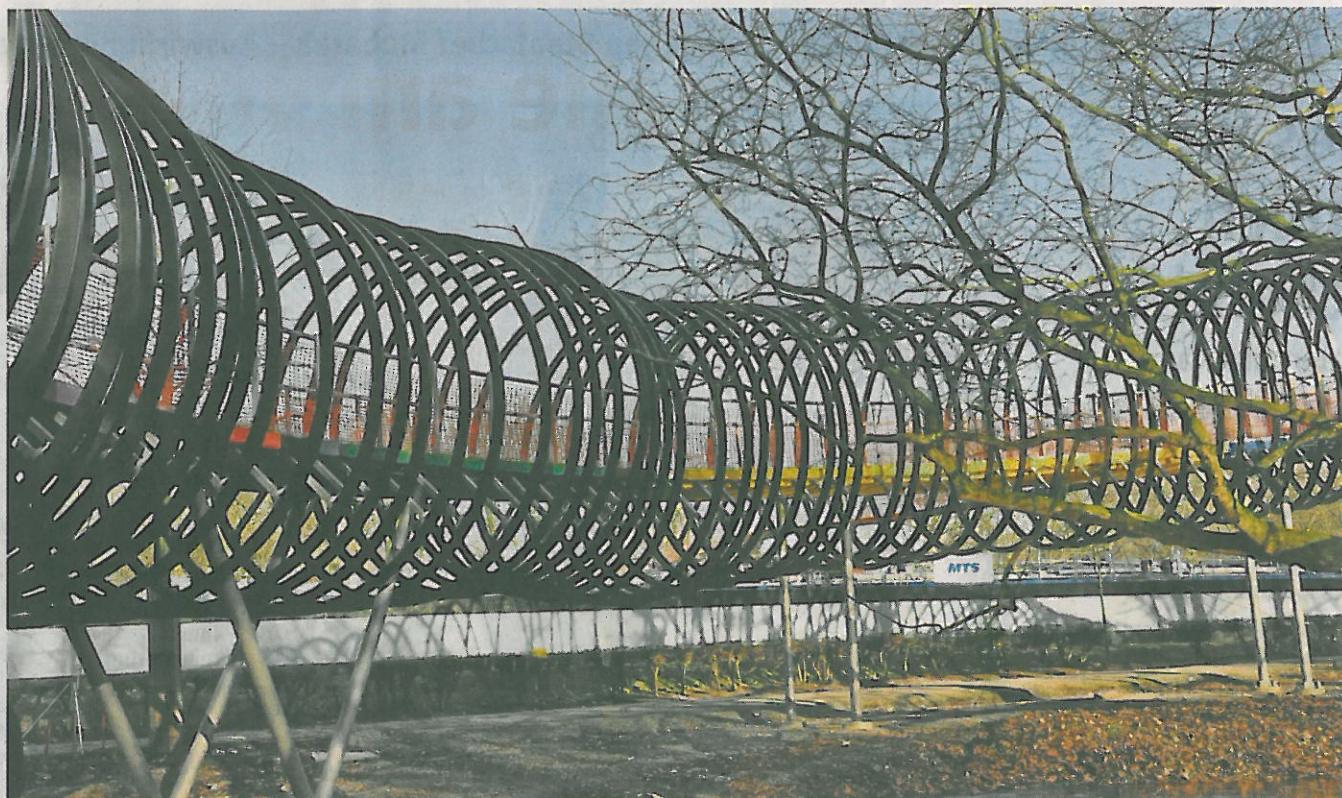
An den beiden Rampen ist die Spirale bereits montiert – ebenso ist an der Unterseite der Betonplatten bereits die Farbgestaltung zu erkennen, die sich später auch auf der Lauffläche wiederfinden wird.
