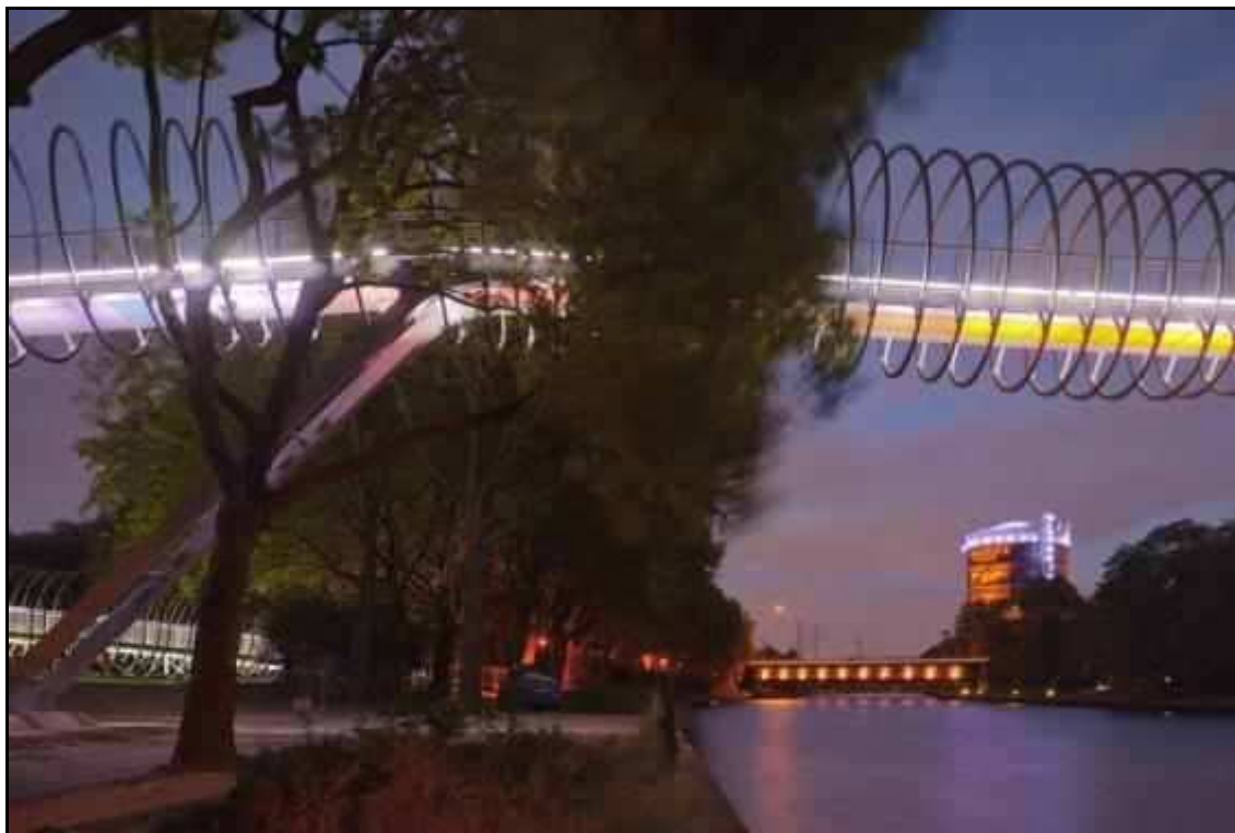
Die Rehberger-Brücke wird ein neues Wahrzeichen von Oberhausen werden. (Foto: Roman Mensing / Emschergenossenschaft)
